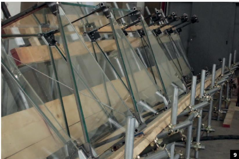
**Figura 9\_** Fase di assemblaggio del secondo piano vetrato verticale
