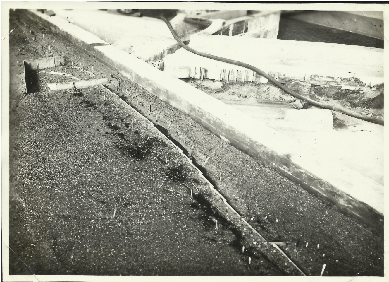
Idraulica: modello spiaggia Marina di Carrara e porto di Carrara
