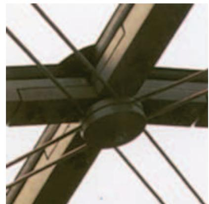
Fig. 9 - Particolare del nodo di collegamento (Tratto da *Konstruktive Lösungen in der High-Tech-Architektur*, Brookes A.J., Grech C.)
