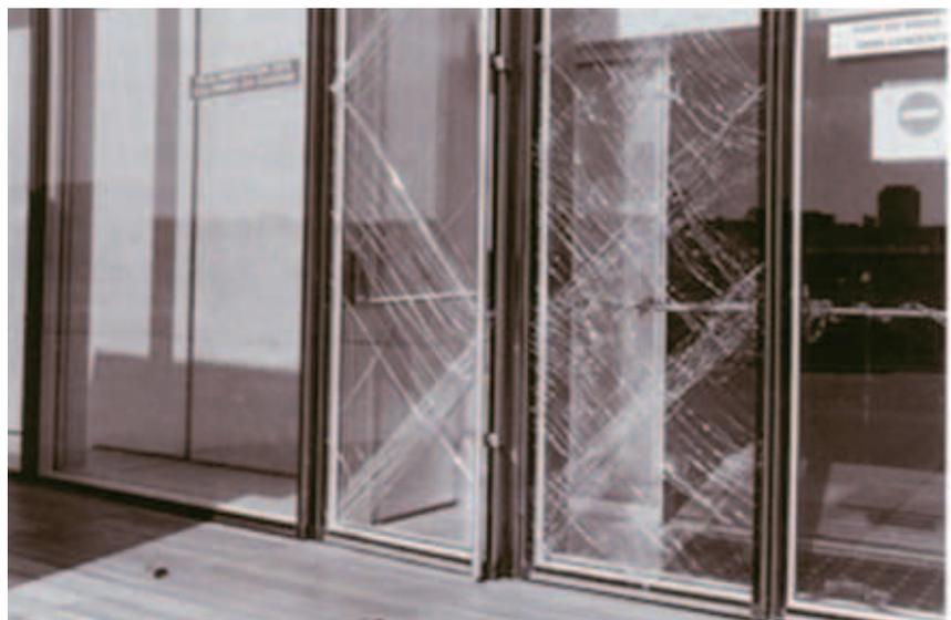
**Fig. 18 - Due esempi di ridondanza strutturale: 1. Confronto tra la resistenza residua di lastre stratificate temperate con e senza armatura metalliche (Immagine archivio ILEK); 2. vetro anti-sfondamento ottenuto con l'accoppiamento a mezzo di laminazione di più lastre di cui almeno una non totalmente temperata: il vetro rimane al suo posto anche a seguito della rottura di tutte le lastre**
