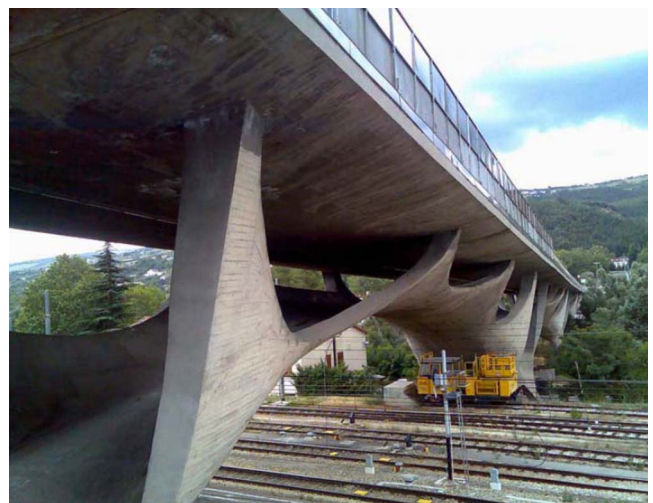
Fig. 4. Musumeci's Ponte sul Basento (bridge over the Basento River), Italy
